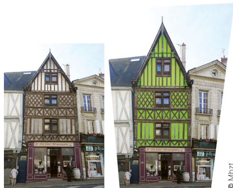
Ci-dessus, à gauche : photo originale. À droite : photo redressée et relevé des surfaces d'enduit (en vert).
